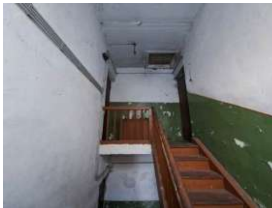
2.stāva kāpņu telpa
