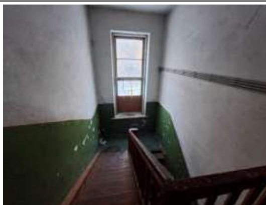
2.stāva kāpņu telpa
